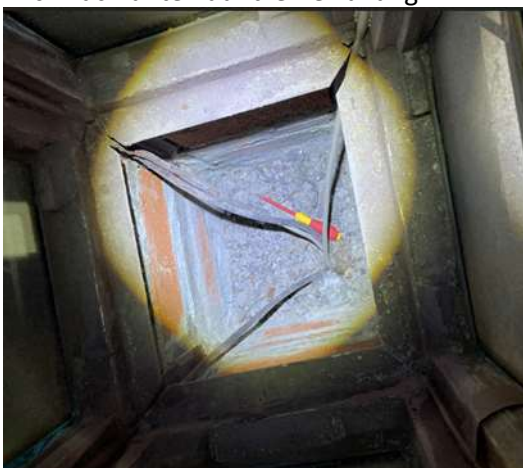
Blick nach unten auf die Verfüllung
