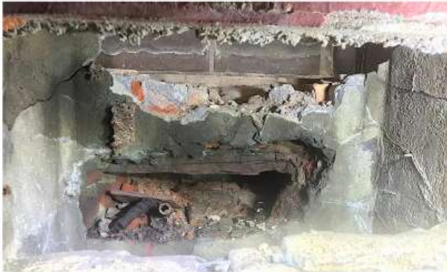
Bild 4 aus 2. Nachtrag: Blick in die Öffnung, im oberen Bereich Blick durch die Öffnung in das obere Becken zum Uhrenturm. Unten eine ältere Öffnung bis auf den Verfüllten Uhrenturmkern.
